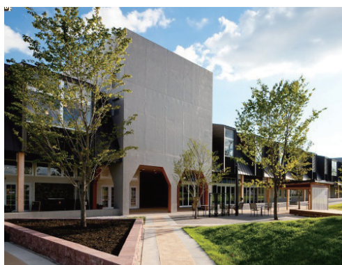
岩手県紫波町の複合施設「オガールプラザ」
