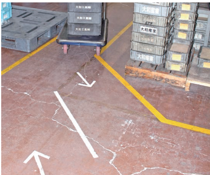
床面に施したペイントで台車の通行もスムーズ
